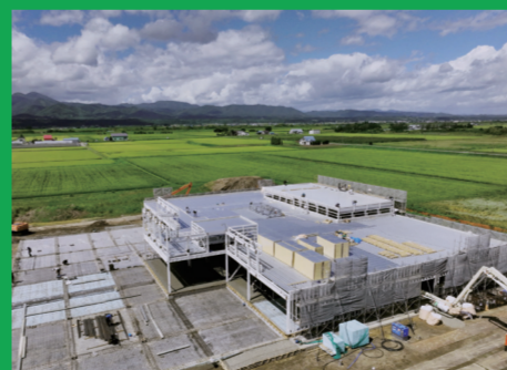
建設中の「みんなの工場」(2022.8時点)
